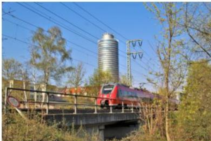
Gemeinsamer Mast für Oberleitung und Bahnstromleitung
