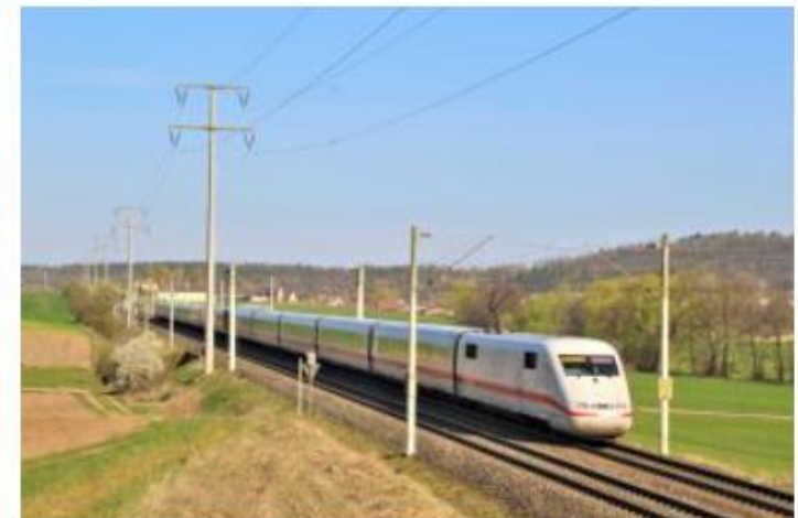
Betonmaste direkt an der Bahnstrecke
