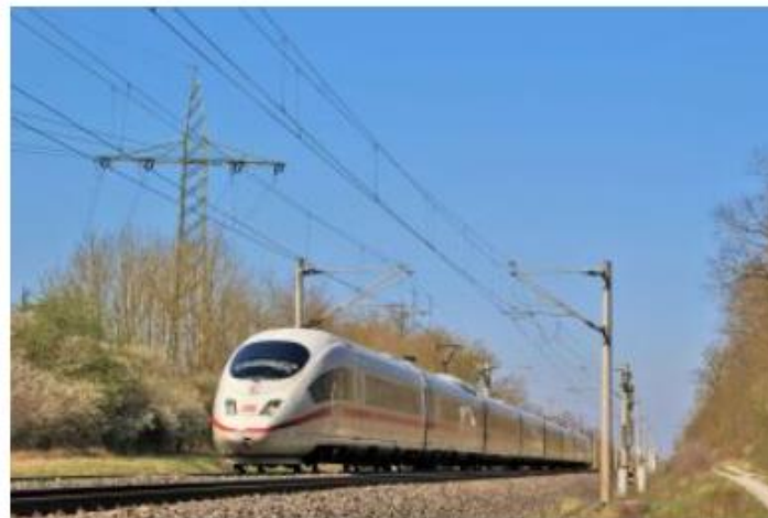
Stahlgittermasten neben der Bahnstrecke
